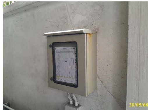
ตู้ควบคุมระบบบำบัดน้ำเสีย
